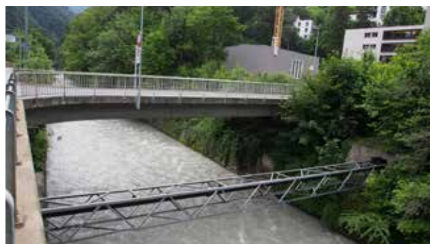
Die Bodmerbrücke und die Werkleitungen, fotografiert am 08.06.2018.
