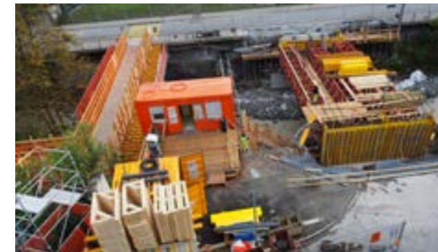
Provisorium, die neue Bodmerbrücke im Bau, fotografiert am 19.09.2018.
