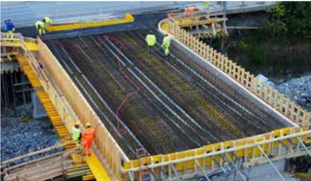
Die Seile zur Brückenspannung wurden innerhalb der Bewehrung verlegt und einbetoniert.
