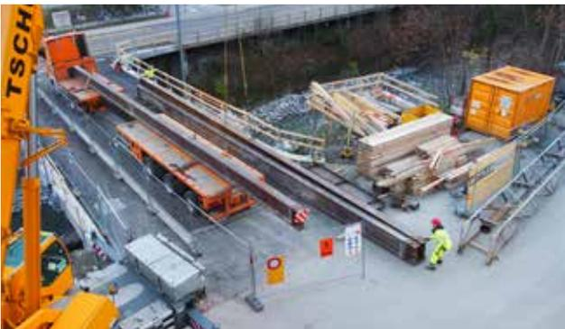
Der Rückbau und Abtransport der Stahlträger der Ersatzbrücke erfolgte in einer Nachtschicht.
