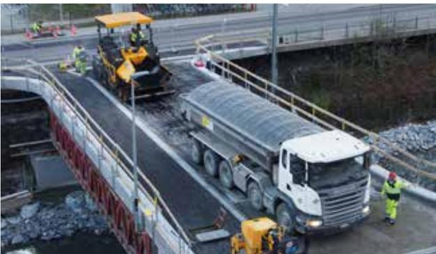
Für die Belagsarbeiten waren zehn Fahrten mit insgesamt ca. 100 Tonnen (43m<sup>3</sup>) Belag nötig.
