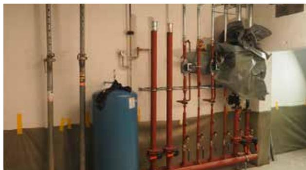
Der Heizungsverteiler im Untergeschoss wird mit Erdwärme das Haus am Mühlbach beheizen.
