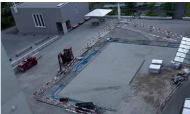
Der Unterboden wird vorgängig mit Kies planiert.
