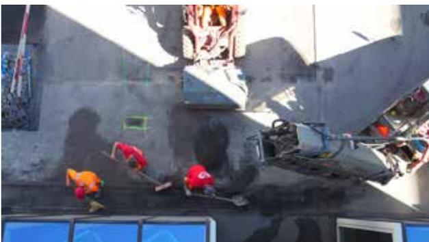
Teile vom alten Teerboden rund um den Platz wurden für den Niveaueausgleich maschinell abgetragen.
