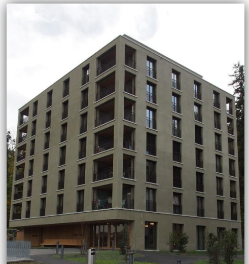
Haus am Mühlbach Bodmerstrasse 34
