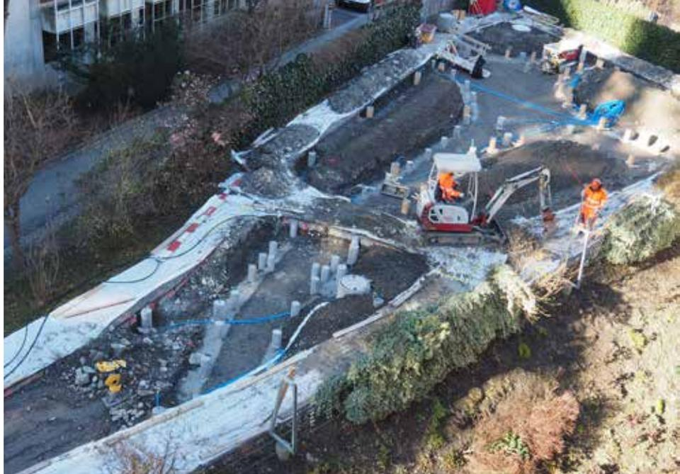
*Die Betonierungsarbeiten und der Kabeleinzug für die Stehleuchten sind abgeschlossen.*
